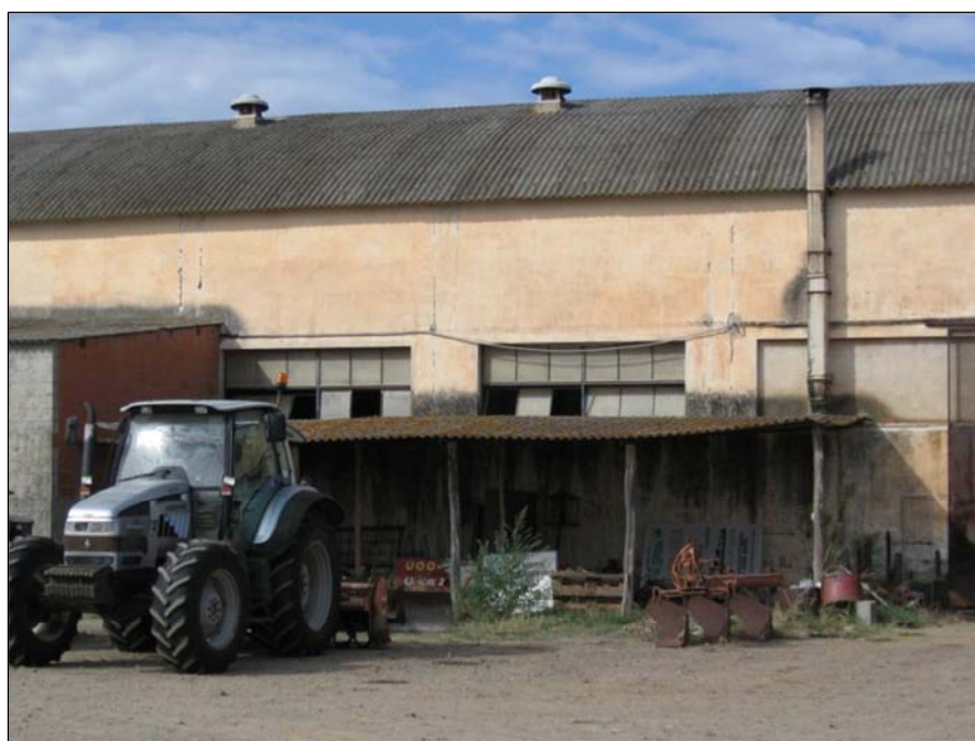
Ricovero attrezzi e macchine agricole. In evidenza la canna fumaria del cammino sito all'interno del locale officina
