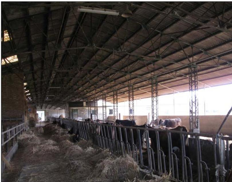
Interno della vaccheria. Da notare la struttura di sostegno realizzata con pilastri e capriate in travi reticolari.
