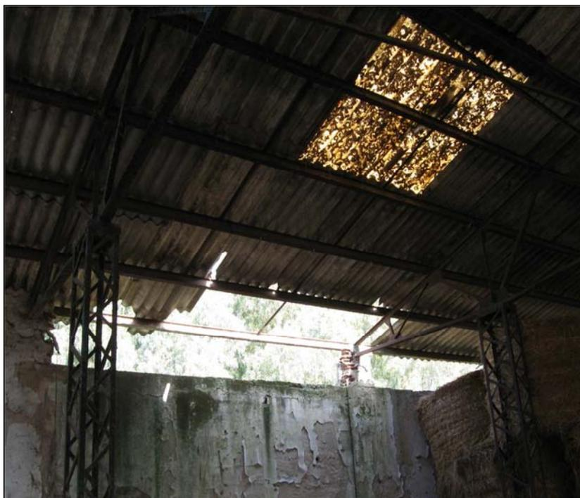
Particolare delle aperture di aerazione da chiudere. In evidenza anche una lastra di copertura traslucida.
