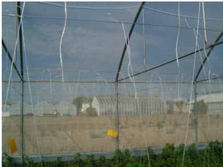
Fig. 1 – Particolari della struttura e della rete visti dall'interno
