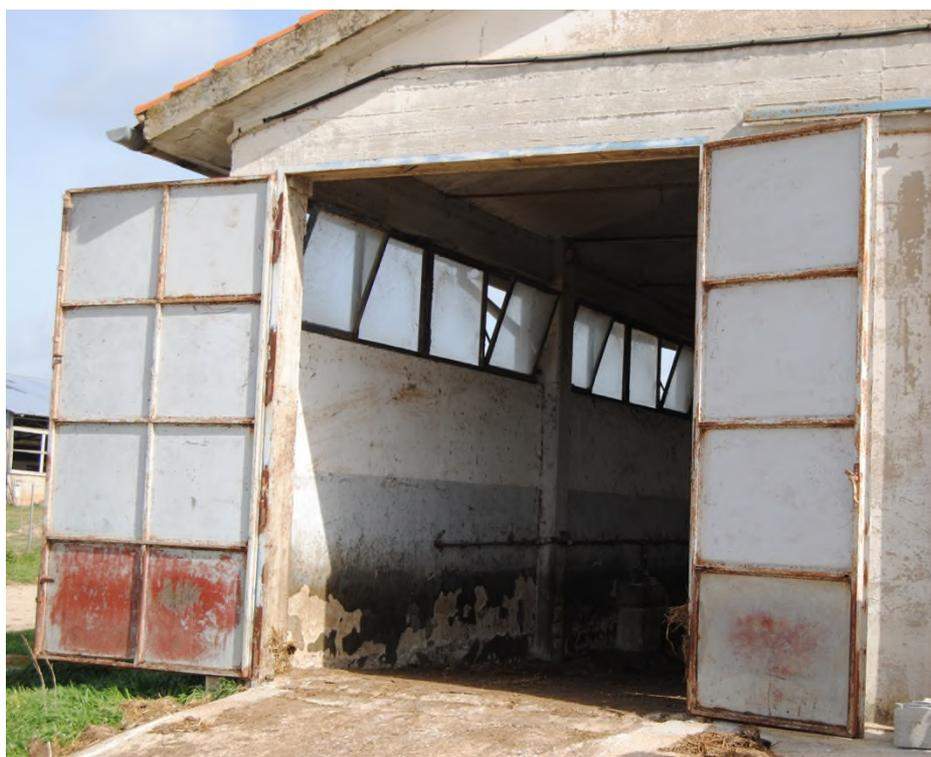
*Ovile sperimentale – Particolare portone n. 2 a due ante - dim. m 2,80 x 3,20 da sostituire.*
