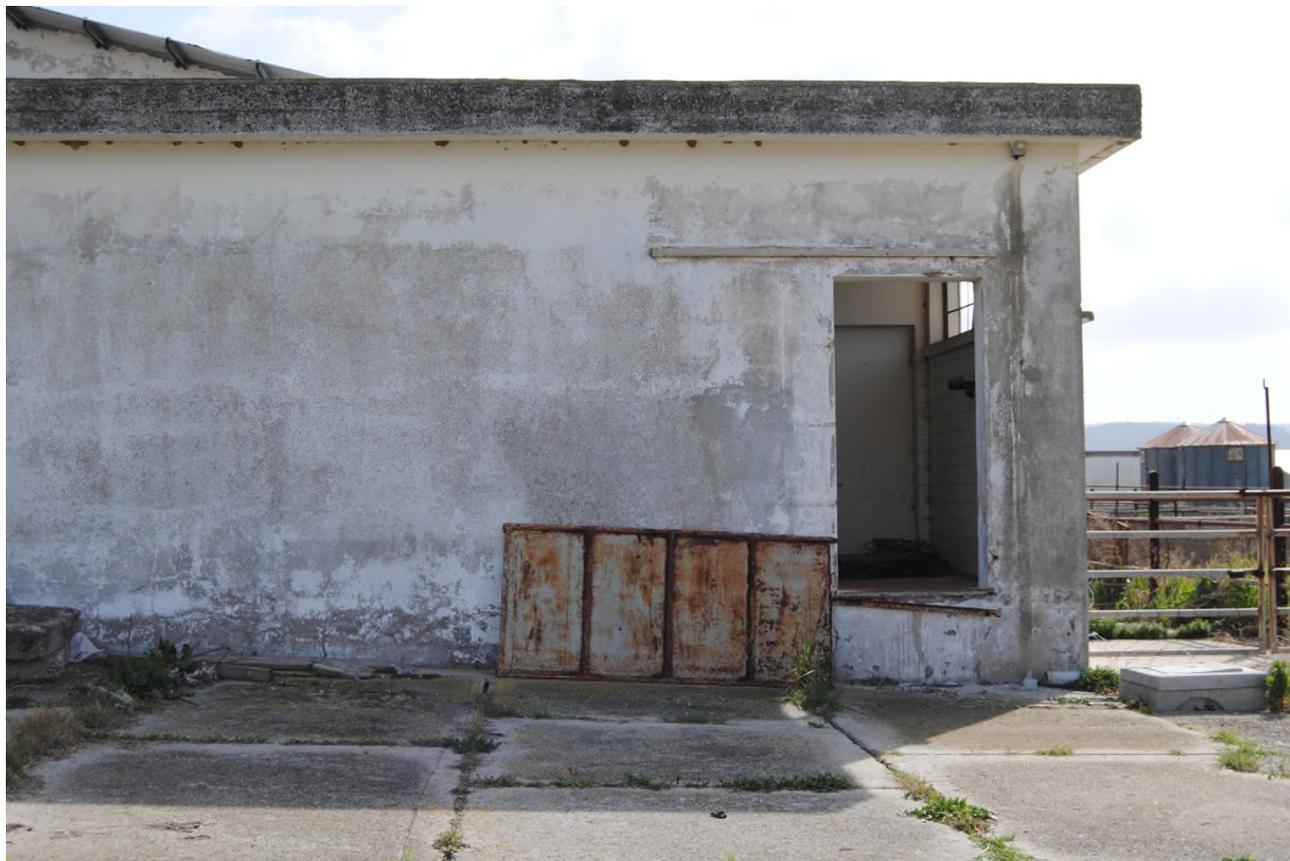
*Vitellaia – Particolare portone scorrevole n. 1 - dim. m 1,10 x2,30 da sostituire.*
