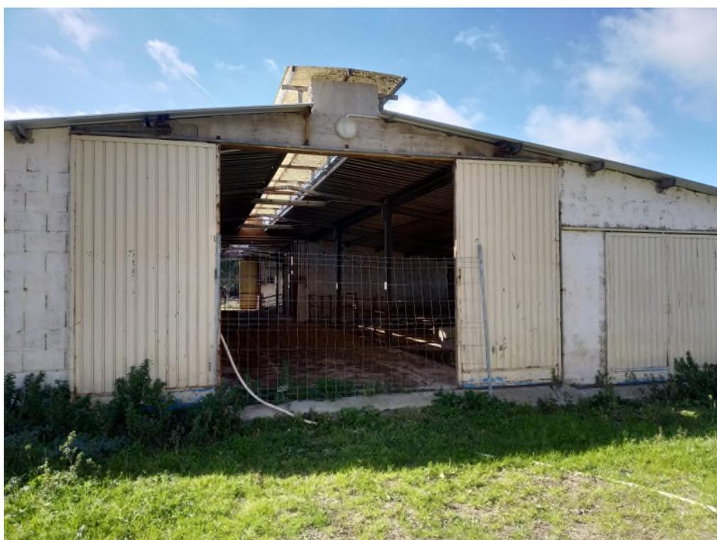
*Caprile fotoperiodo – Particolare portoni n. 2 - dim. 3,20 x 3x20 da sostituire.*
