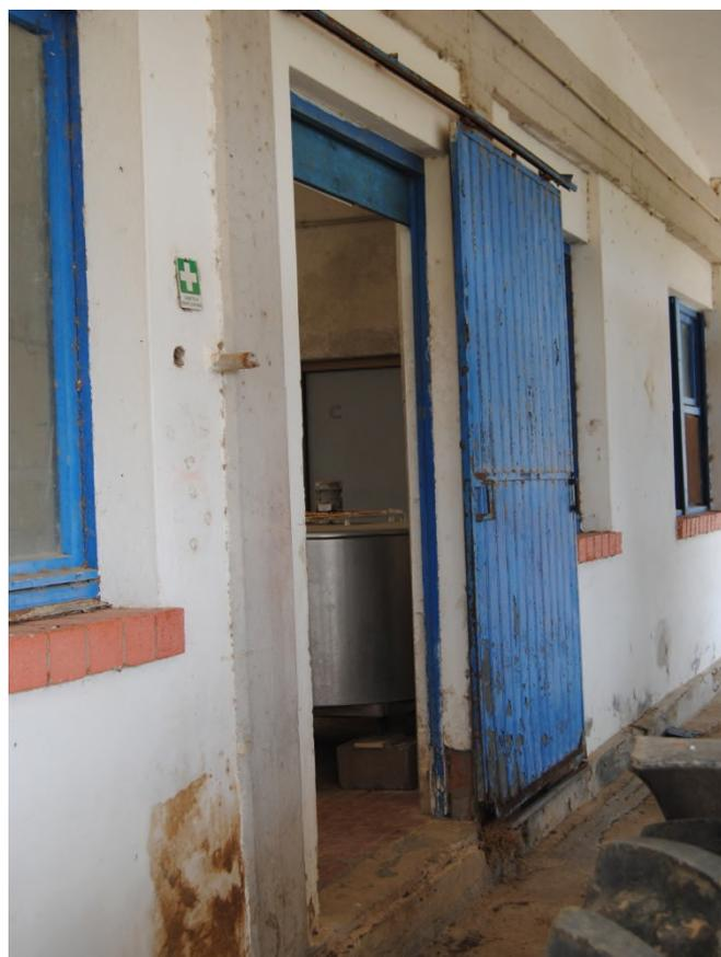
*Ovile sperimentale – Particolare portone scorrevole n. 1 - dim. m 1,20 x2,60 da sostituire*
