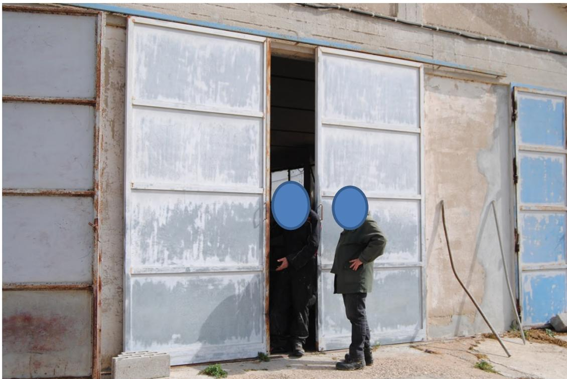
*Ovile sperimentale – Particolare portone n. 1 a due ante scorrevoli - dim. m 3,20 x 3,20 da sostituire*
