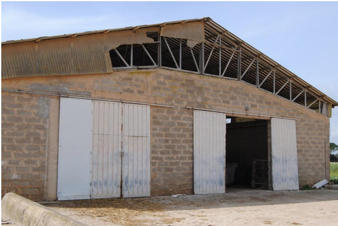
*Caprile – Particolare portoni nn. 1 e 2 - dim. 3,20 x 3x20 da sostituire.*
