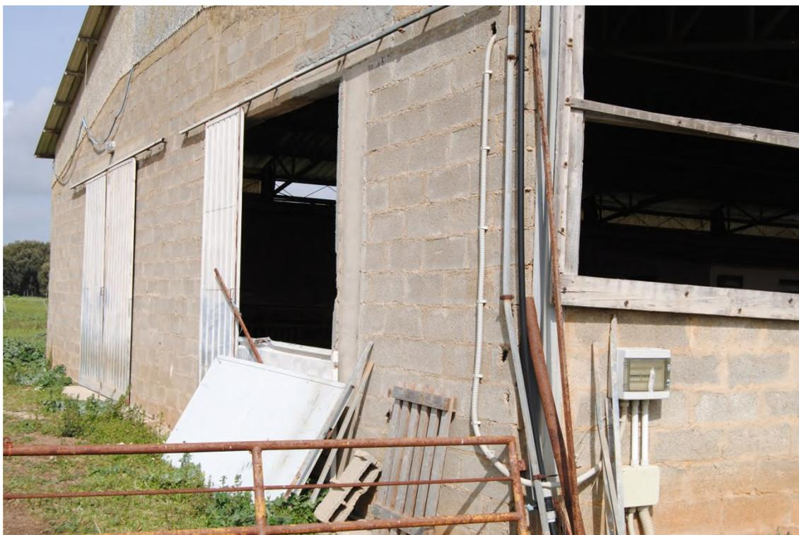
*Caprile – Particolare portoni nn. 3 e 4 - dim. 3,20 x 3x20 da sostituire.*
