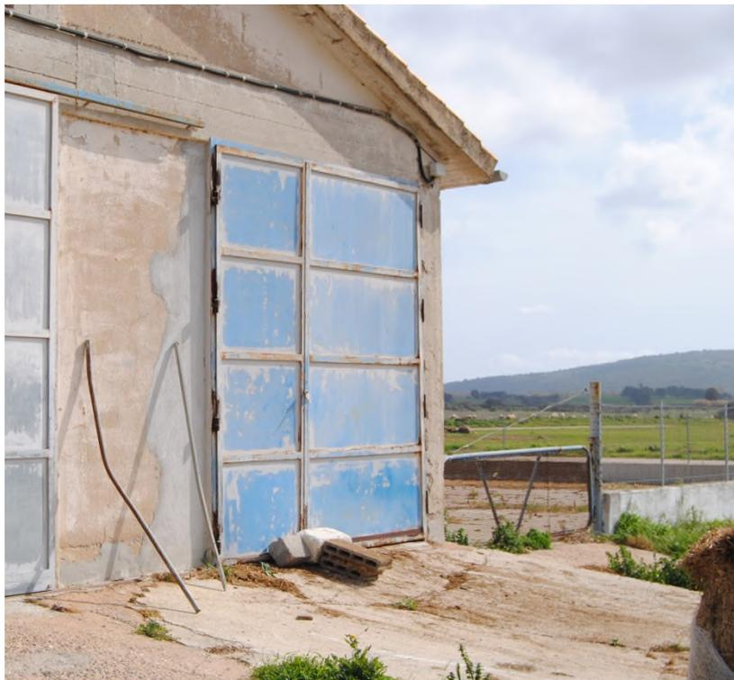
*Ovile sperimentale – Particolare portone n. 1 a due ante - dim. m 2,80 x 3,20 da sostituire.*
