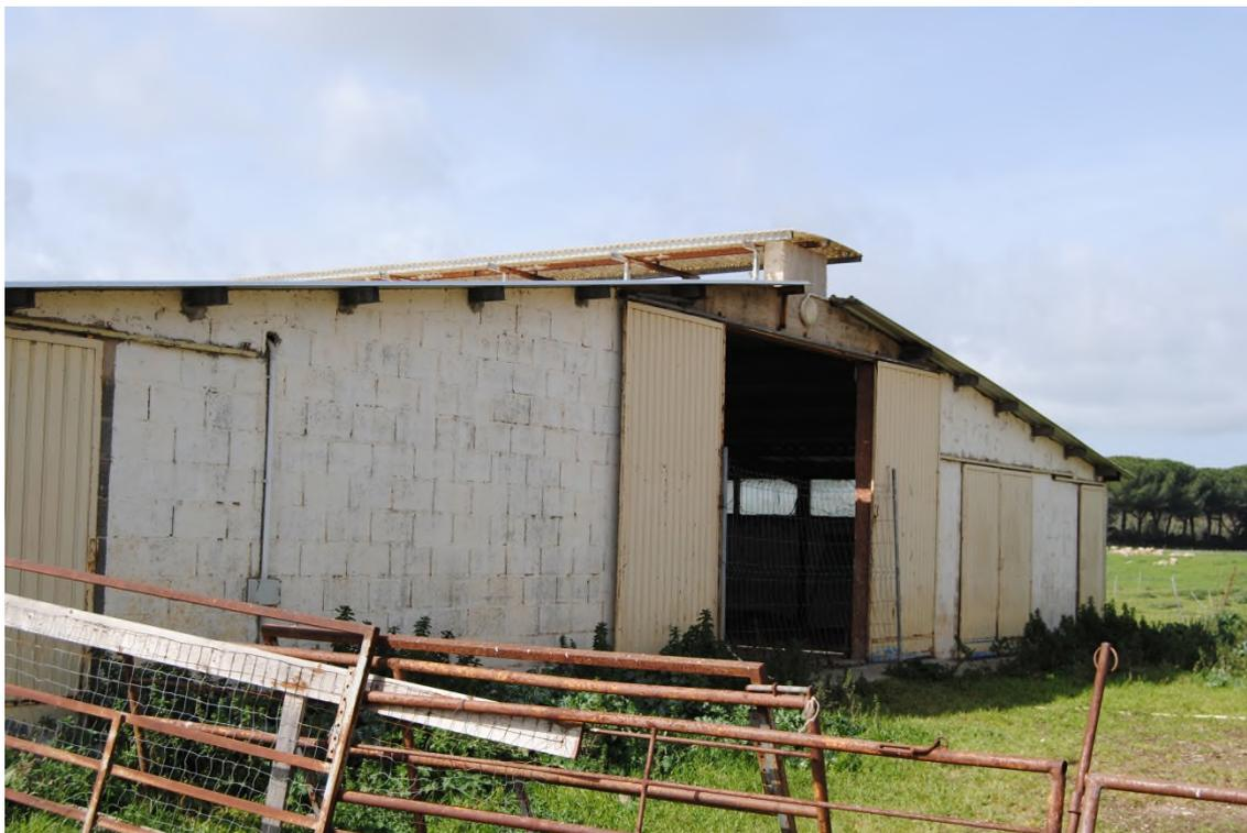
*Caprile fotoperiodo – Particolare portoni n. 1 - dim. 3,20 x 3x20 da sostituire.*
