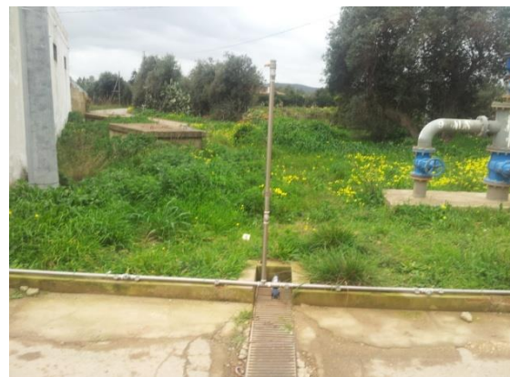
Foto 3 e 4 – Impianto disinfezione automezzi
