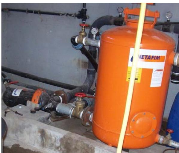
Foto 9 - Stazione di filtraggio con filtri a graniglia e a dischi
