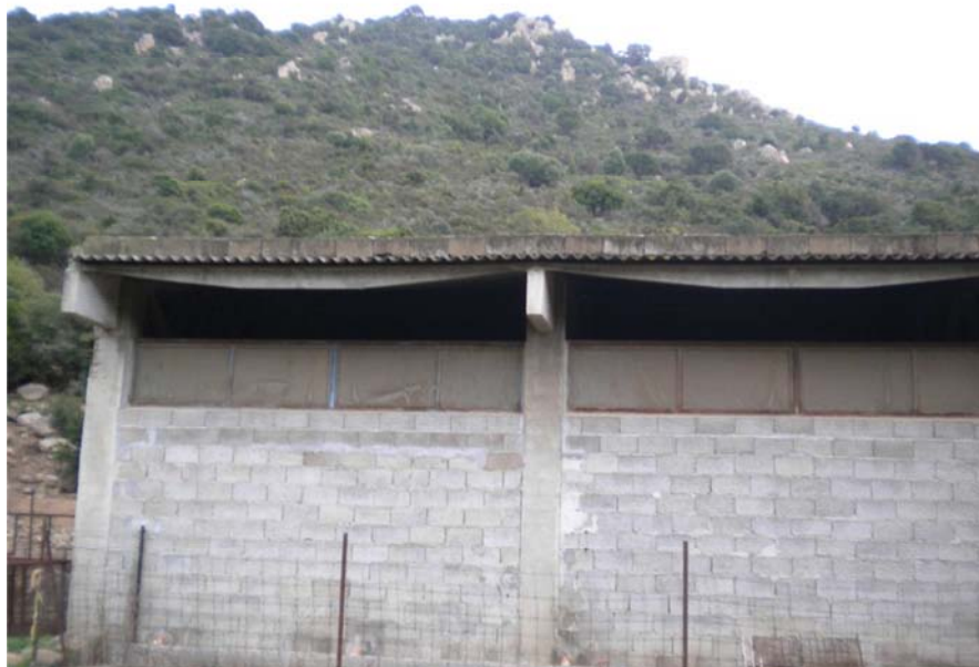
Foto 2 Particolare della struttura portante
